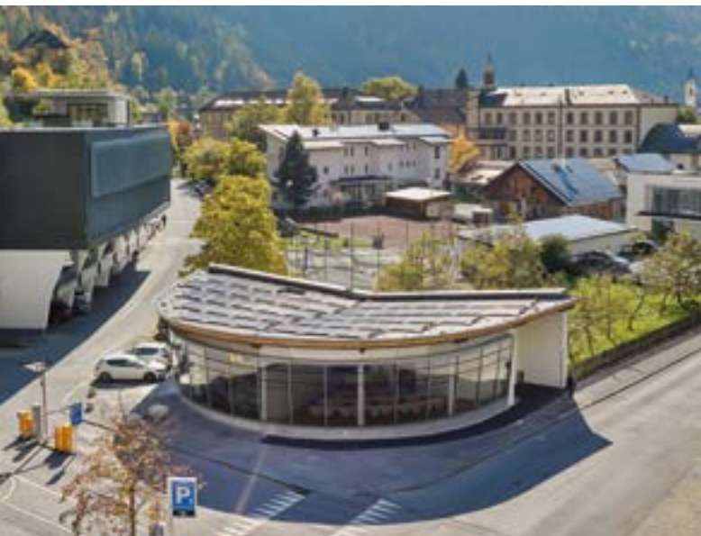
Der Pavillon bietet großzügigen Raum, der sowohl für den Unterricht als auch als Veranstaltungsort für bis zu 70 Personen genutzt werden kann.
